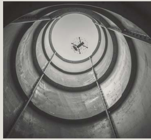
プラント内を飛行する点検用ドローン 福島ロボットテストフィールド
